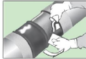
Mezcle el epoxy por 1(Curado) a 3(Base), aplique imprimación epoxy mixta con un espesor mínimo de 0.15mm.
